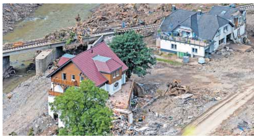
Zerstörungen nach der Flutkatastrophe im Ahrtal 2021.
